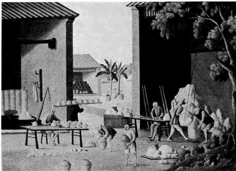
AFB. 12. HET AANPLAKKEN VAN TUITEN EN HENGSELS, HET BOETSEREN VAN POPPETJES EN HET COMPLETEREN DER MARTAVAEN
